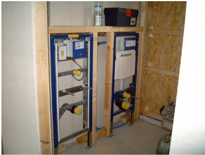
Geberit-Unterputzträger für Bidet und WC.
