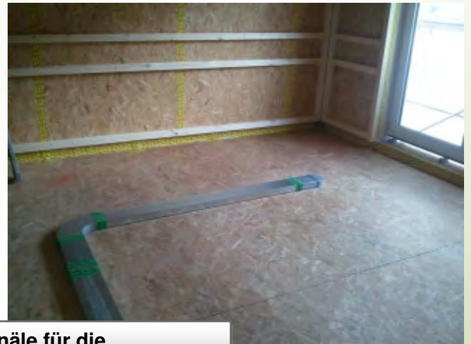
...je nach Anwendung werden unterschiedliche SIGA-Bänder (= andere Farbe) verwendet.
