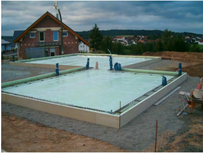
Bodenplatte bereit zum betonieren
