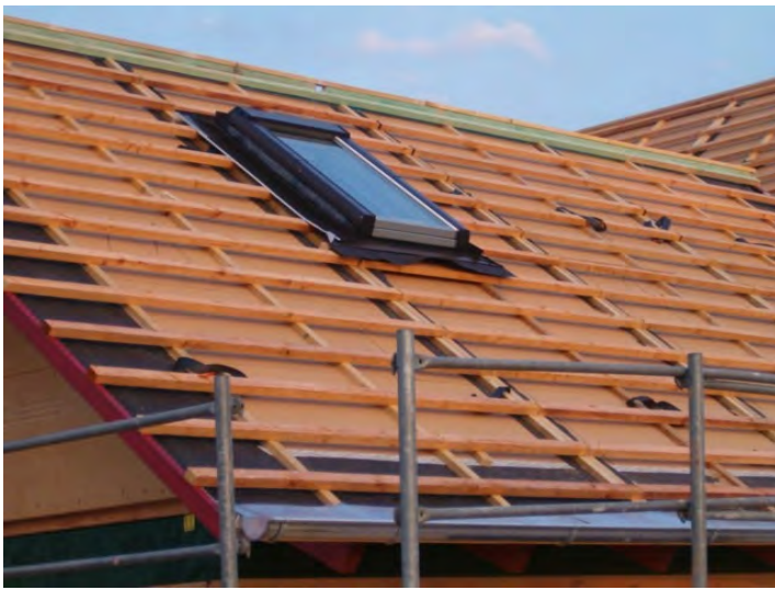
Dachfenster mit Rollladen.
