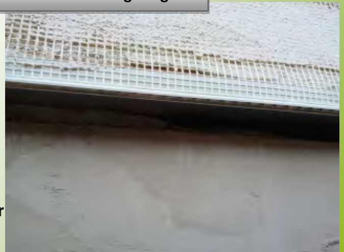
Grundputz mit Gewebe und Anputzleisten wird aufgetragen.
