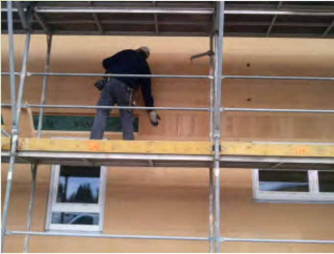
SIGA-Bänder zur Herstellung einer luftdichten Gebäudehülle...
