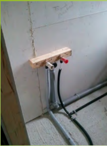
Unterkonstruktion für Waschbecken.
