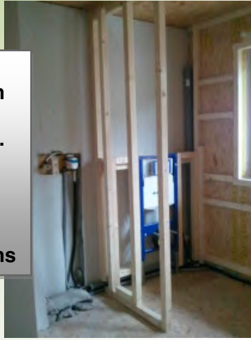
Kabelverlegung über Boden und Innenwand.
