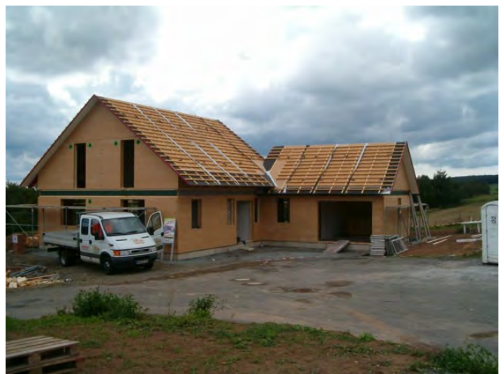
Ende des 2. Tages. Der „Rohbau“ ist fertig. An den nächsten Tagen folgt die Dacheindeckung, der Einbau der Fenster und der Haustür.
