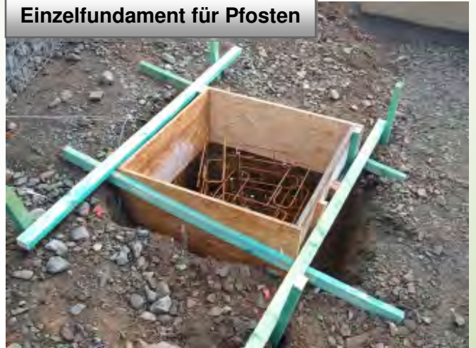
Zusatzbewehrung an wichtigen Lastpunkten
