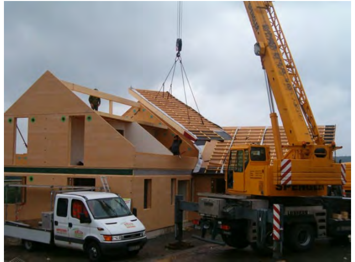
Ein Deckenelement schwebt auf seine Position.
