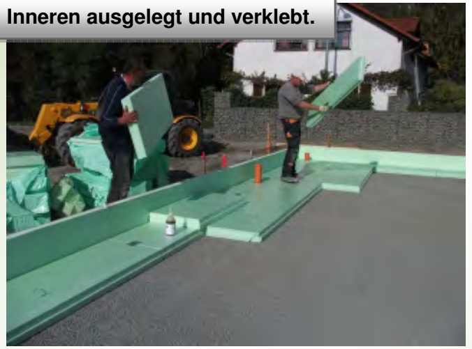
Die zweite Dämmlage liegt jetzt auf der ersten. Die Dämmung der doppelagigen Bodenplatte ist somit fertiggestellt.
