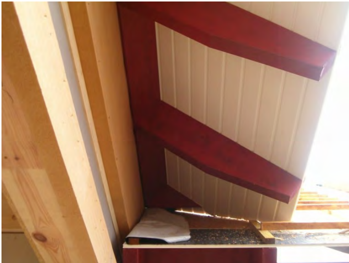
Sparren mit Untersichtschalung, gefärbt nach Kundenwunsch, völlig individuell.
