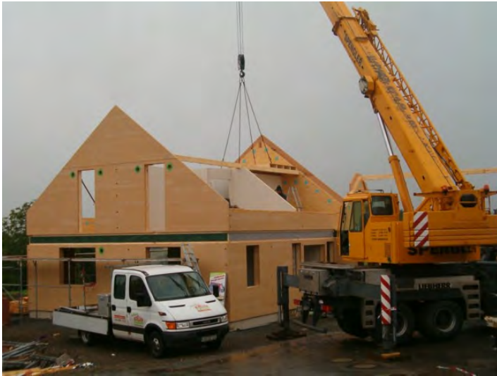
Giebelspitzen, Kehlbalckendecke und Pfetten Werden montiert.
