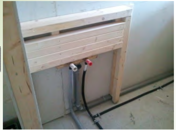
Unterkonstruktion für Waschbecken.
