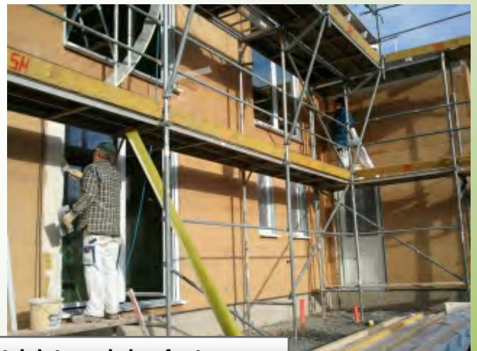
Grundputz mit Gewebe und Anputzleisten wird aufgetragen.
