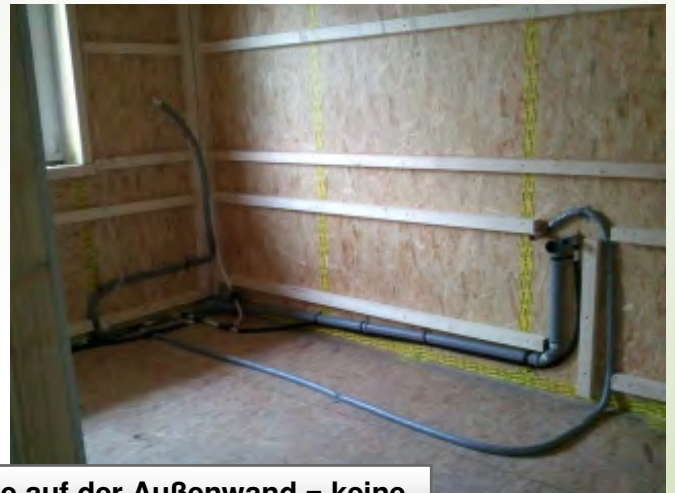
Herstellung einer Installationsebene auf der Außenwand = keine Durchdringung der Hauptdämmebene durch Rohre oder Kabel.
