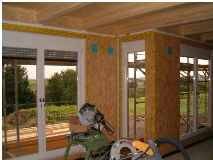
Die Wand ohne Installationsebene
