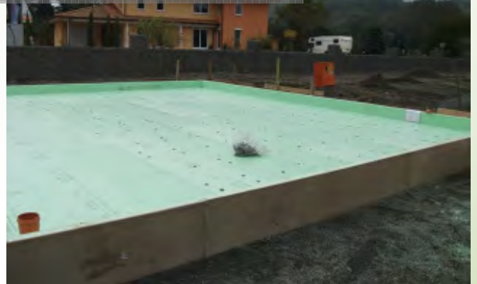
Die zweite Dämmlage liegt jetzt auf der ersten. Die Dämmung der doppelagigen Bodenplatte ist somit fertiggestellt.
