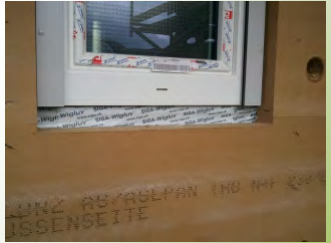
SIGA-Bänder zur Herstellung einer luftdichten Gebäudehülle...
