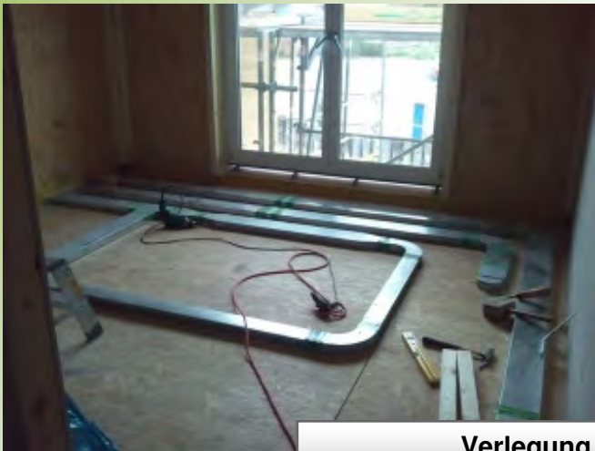
...je nach Anwendung werden unterschiedliche SIGA-Bänder (= andere Farbe) verwendet.
