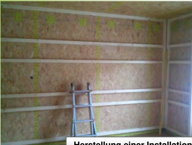
Herstellung einer Installationsebene auf der Außenwand = keine Durchdringung der Hauptdämmebene durch Rohre oder Kabel.
