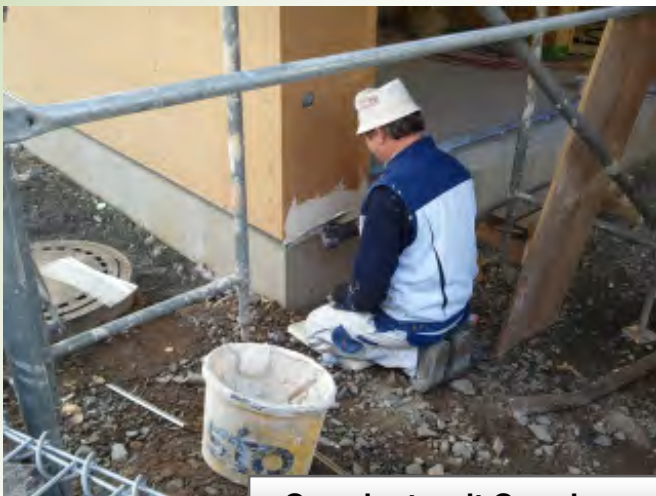
Grundputz mit Gewebe und Anputzleisten wird aufgetragen.
