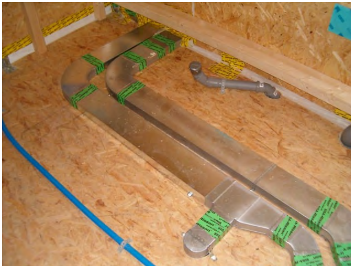
Verlegen der Lüftungskanäle mit Abluftventilen.
