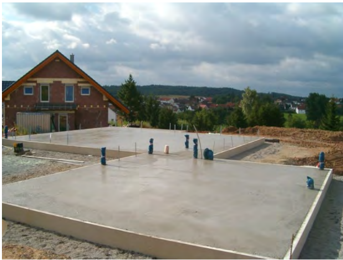
Die fertige Bodenplatte. Das Haus kann kommen....
