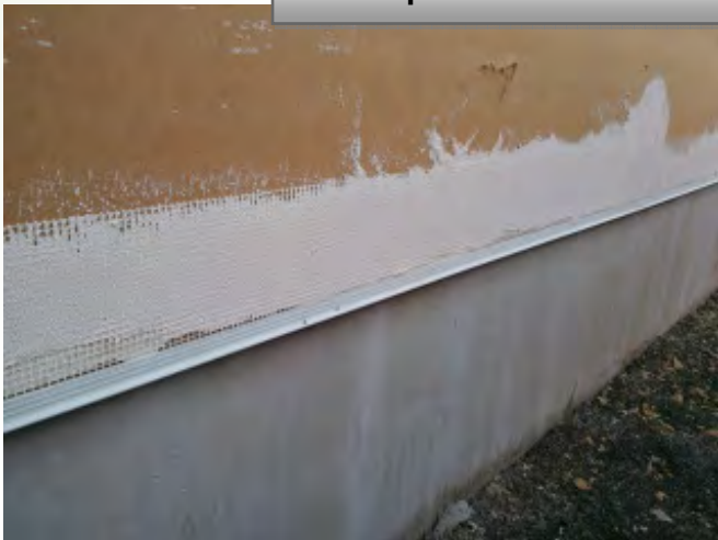
Grundputz mit Gewebe und Anputzleisten wird aufgetragen.
