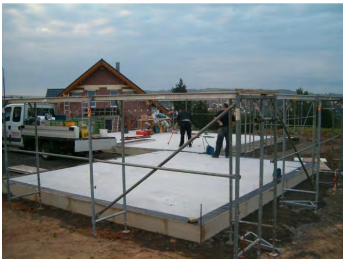
Vorbereitungen zur Montage der EG-Wände.
