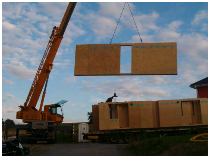
Die Wände werden vom LKW gehoben...
