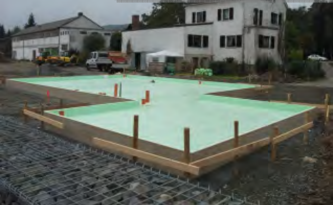
Die zweite Dämmlage liegt jetzt auf der ersten. Die Dämmung der doppelagigen Bodenplatte ist somit fertiggestellt.
