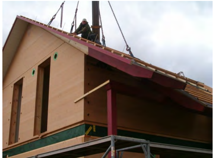
Ein Deckenelement schwebt auf seine Position.
