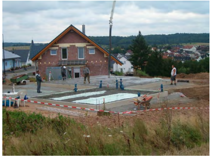
Bodenplatte wird betoniert.
